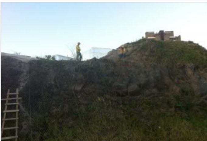
Durante la Obra
