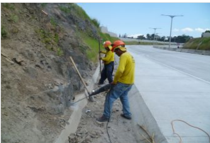
Durante la Obra
