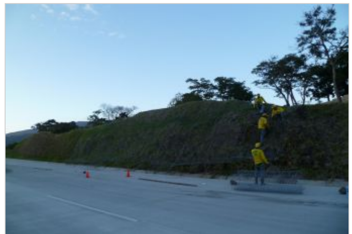
Durante la Obra
