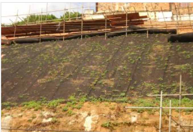
Durante a obra
