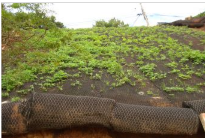
Durante a obra
