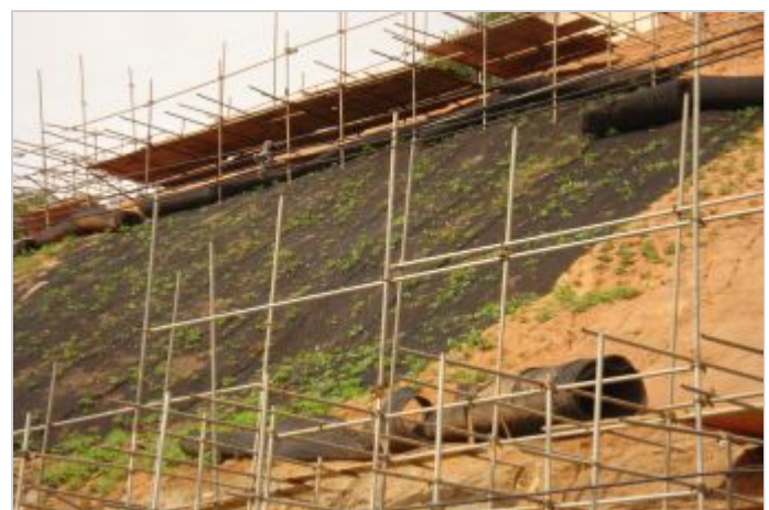
Durante a obra
