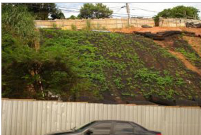
Durante a obra
