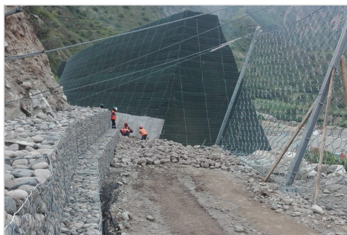
Durante la Obra
