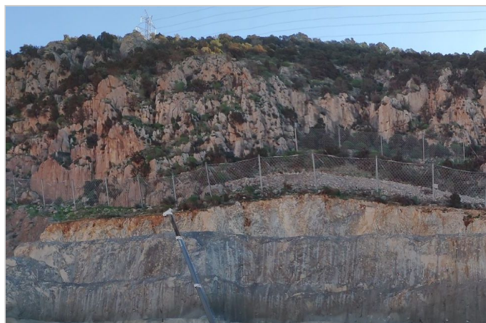
Πανοραμική άποψη μετά τη τοποθέτηση φράκτη και πλεγμάτων προστασίας
