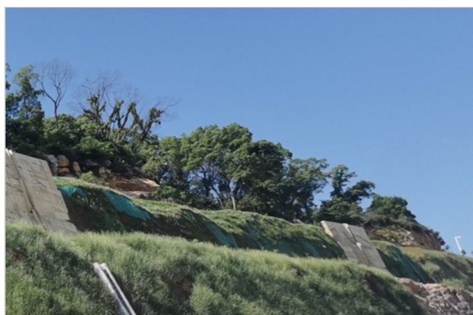
施工完成-后期已完全实现绿化
