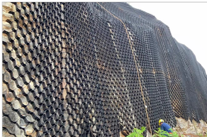
铺设蜂巢格室
