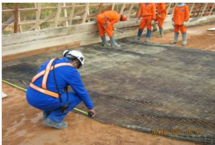
Durante la Obra
