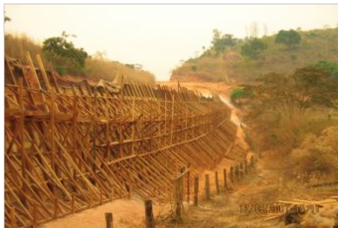
Durante la Obra
