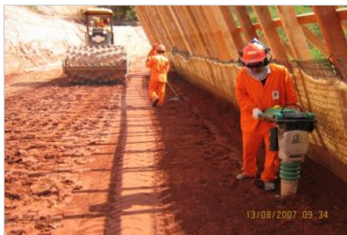
Durante la Obra
