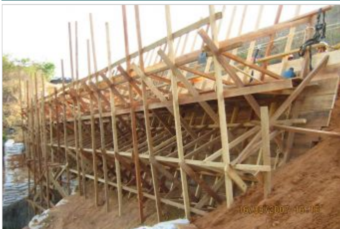
Durante la Obra
