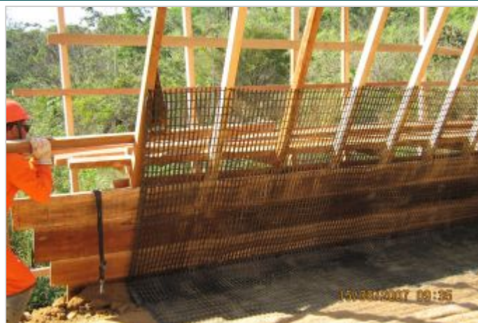
Durante la Obra
