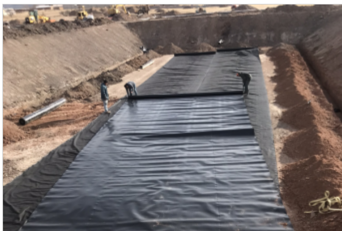
Durante la Obra
