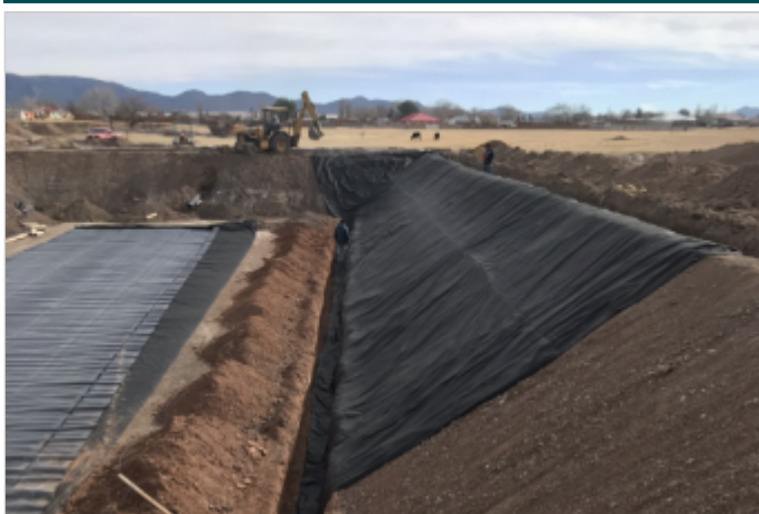
Durante la Obra
