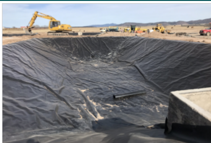
Durante la Obra
