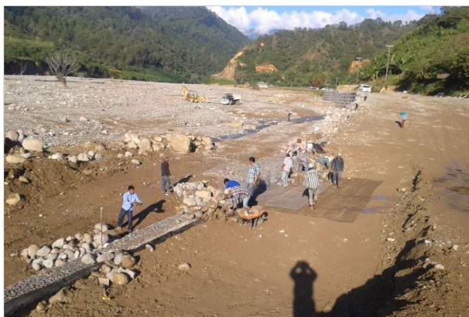
Durante la Obra
