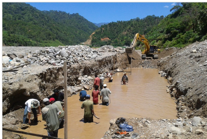
Durante la Obra
