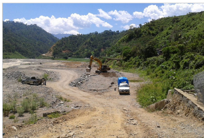
Durante la Obra
