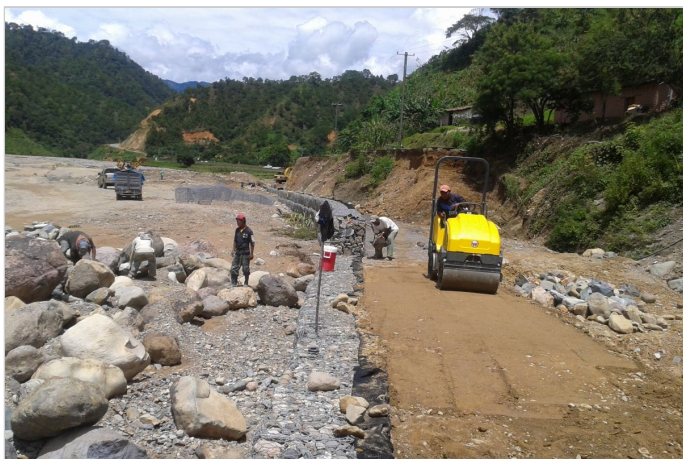
Durante la Obra
