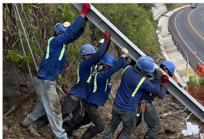
Durante la Obra
