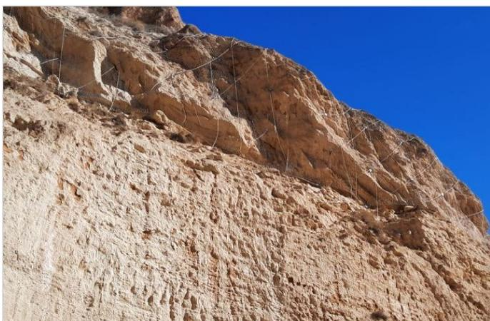
Sostenimiento banco inferior mediante malla y cables cruzados (talud NE)
