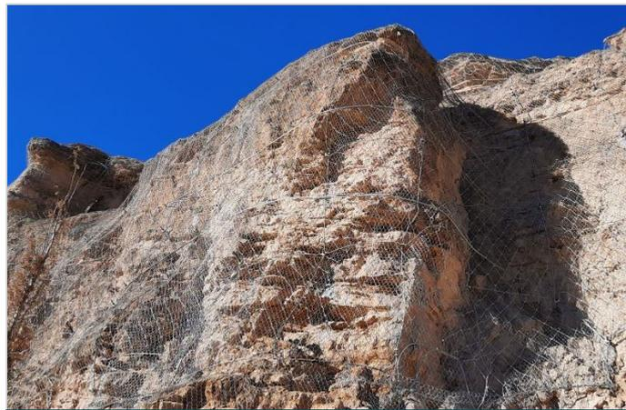
Refuerzo mediante fajas de cable y anclajes de cable (bloque 2)
