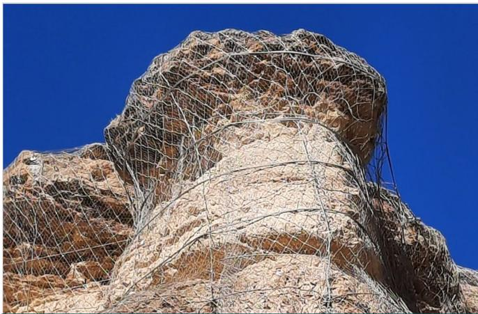
Refuerzo mediante fajas de cable y anclajes de cable (bloque 1)
