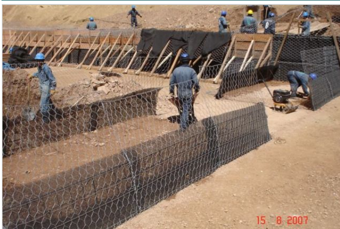
Durante la Obra
