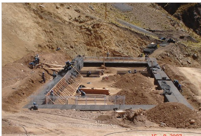
Durante la Obra
