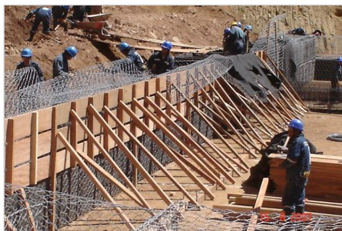
Durante la Obra
