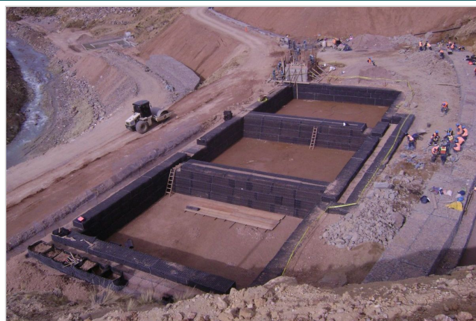
Durante la Obra
