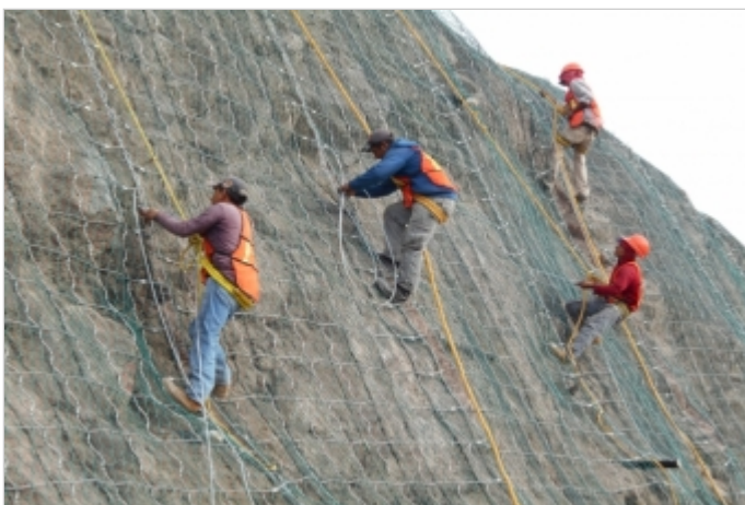
Durante la Obra
