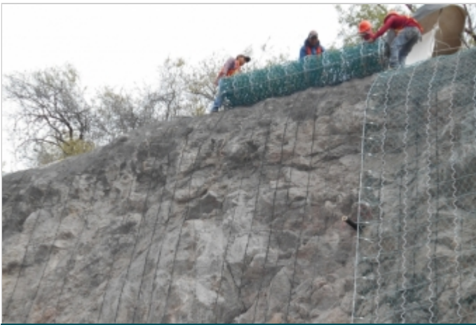
Durante la Obra
