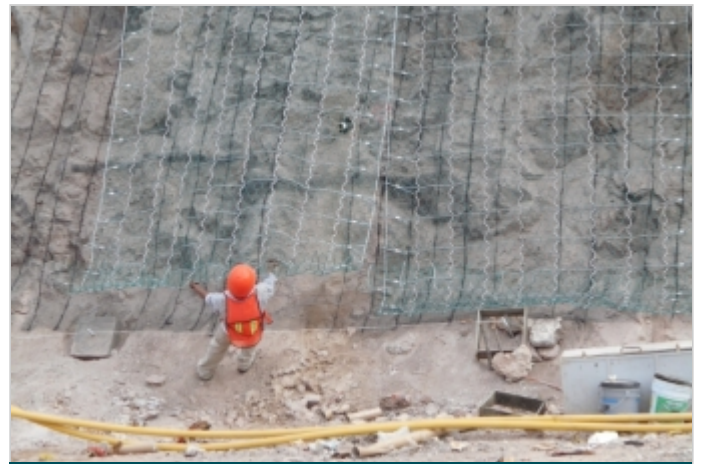
Durante la Obra
