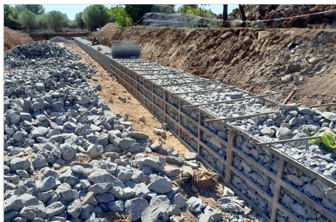
Pendant les travaux
