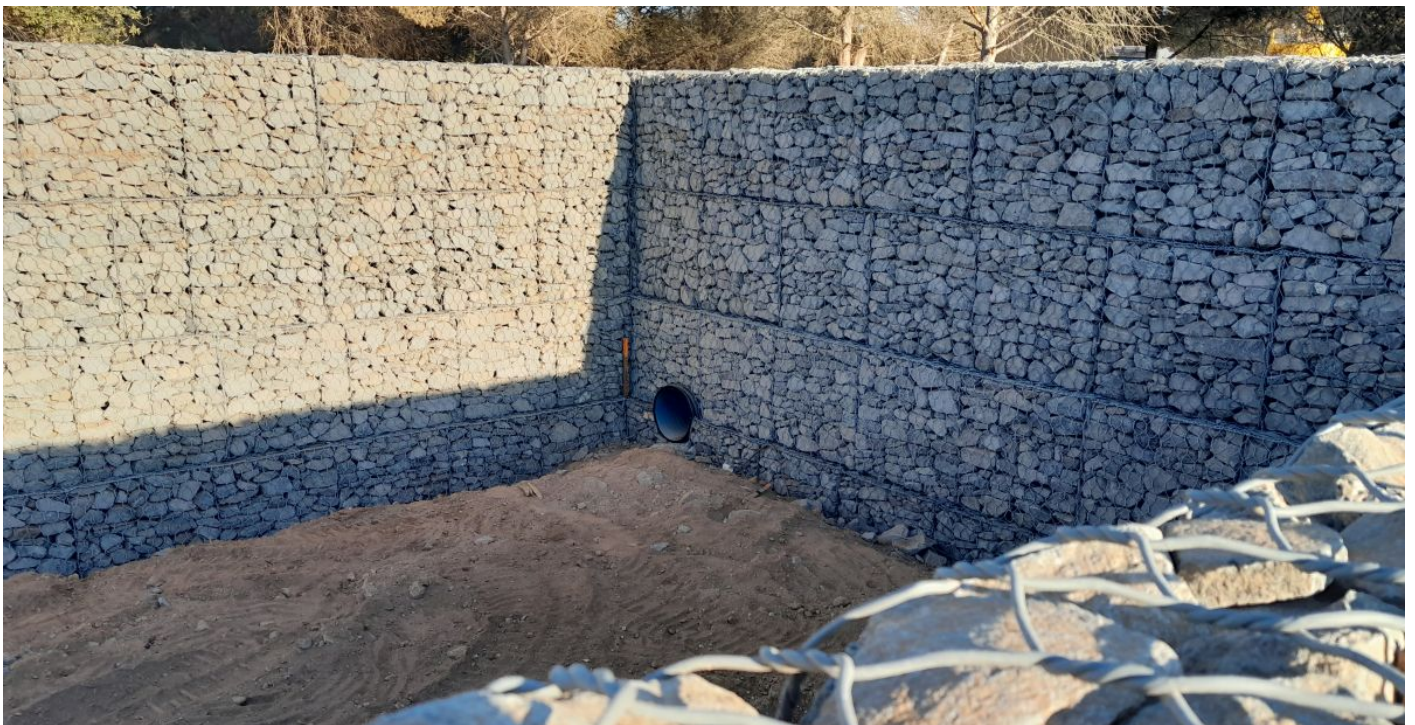
A la fin des travaux
