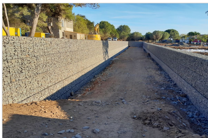
Pendant les travaux
