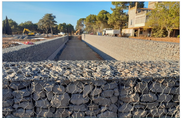
A la fin des travaux
