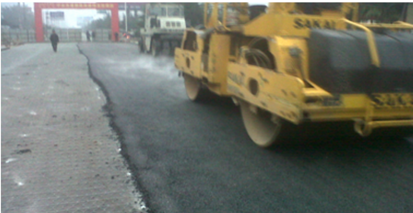
加筋网现场铺设照
