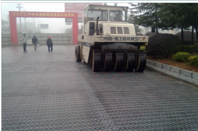
加筋网现场铺设
