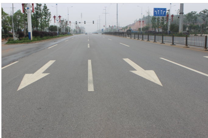
施工后现场照
