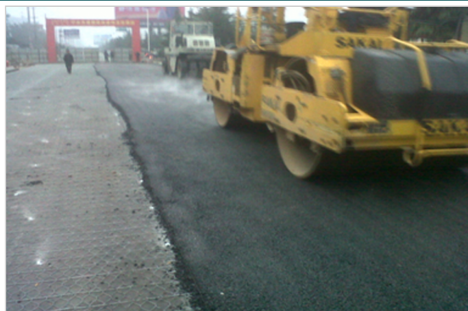
加筋网路面浇筑
