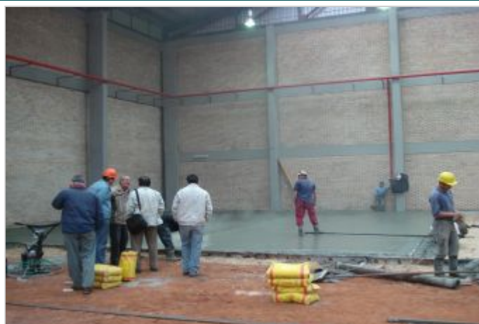
Durante a obra
