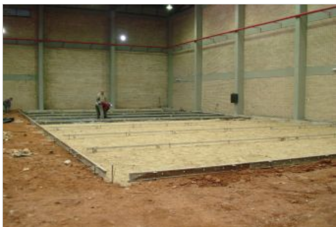
Antes da Obra
