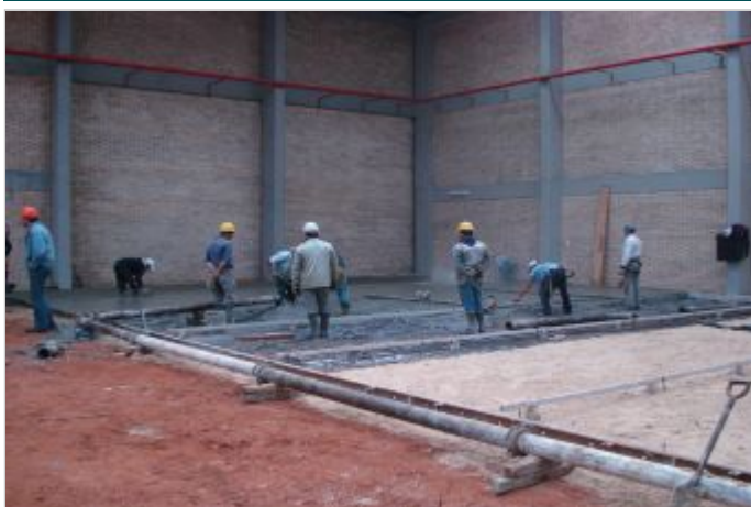
Durante a obra
