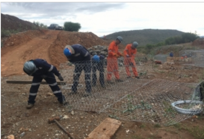
Durante la Obra
