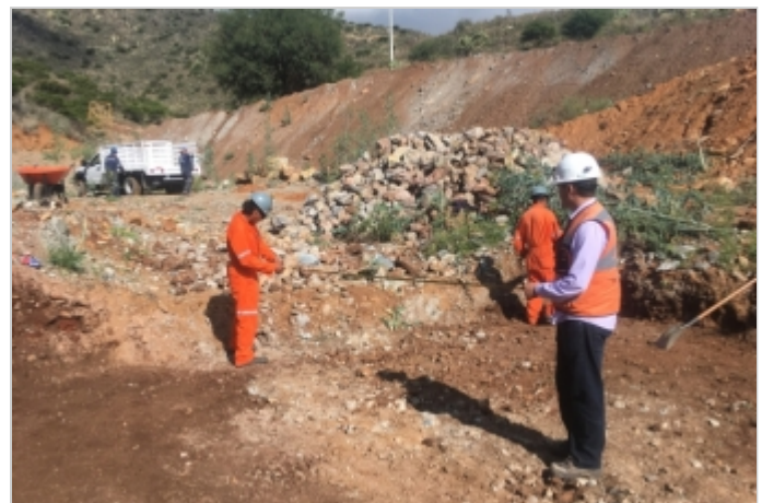
Durante la Obra
