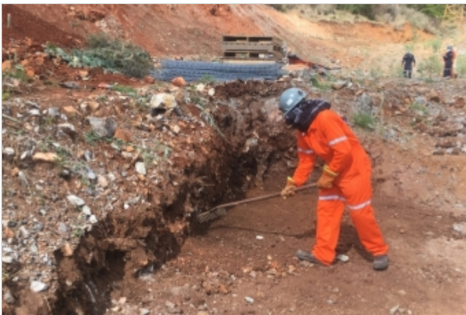
Durante la Obra
