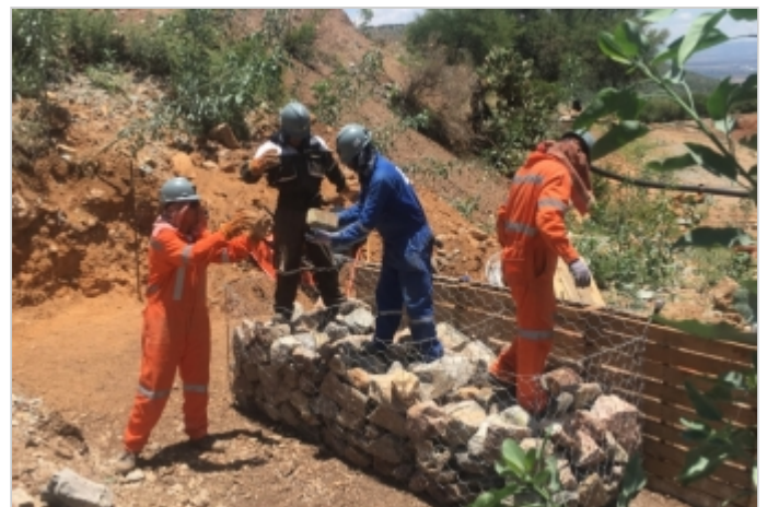
Durante la Obra
