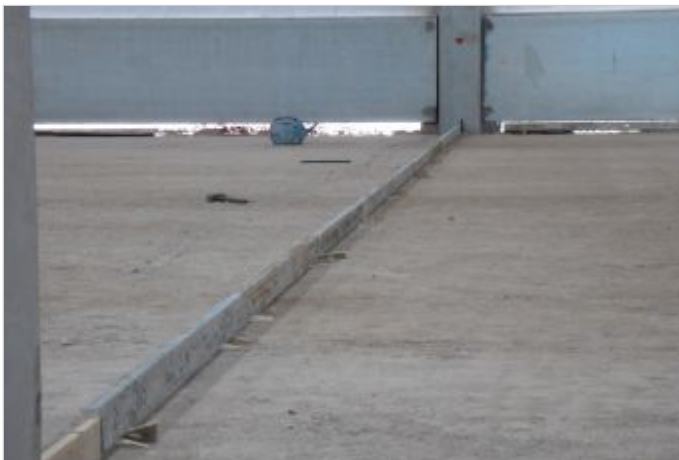
Durante la Obra
