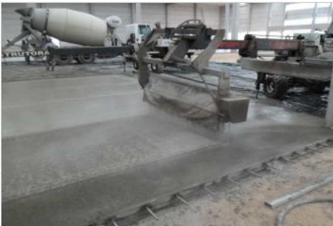
Durante la Obra
