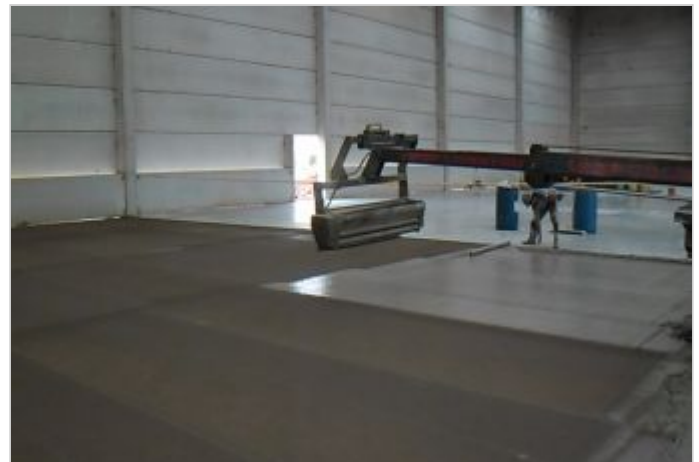
Durante la Obra
