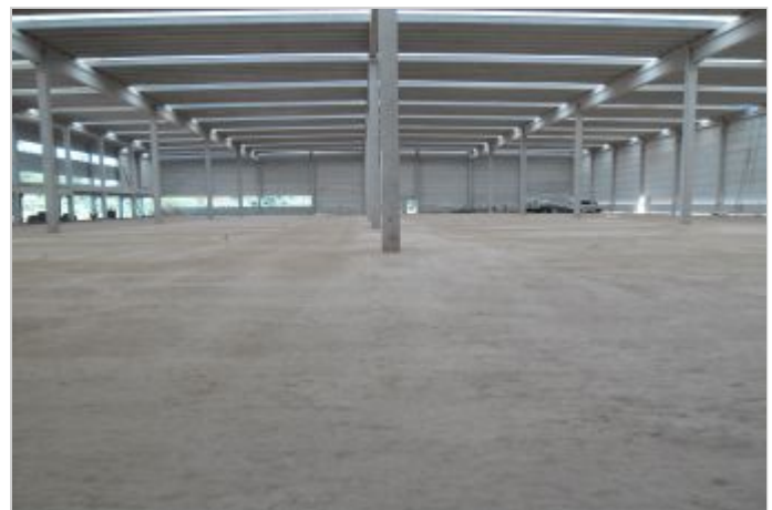
Durante la Obra
