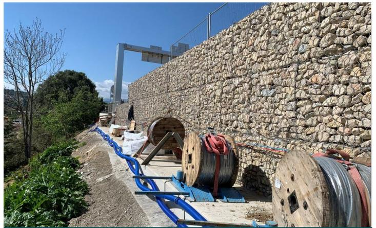
Vue du remblai renforcé et du géocomposite de drainage en cours d'installation | Remblai renforcé - TerraMesh® System
