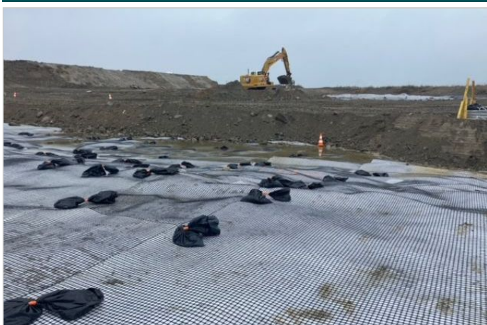
Mise en œuvre de la couverture
