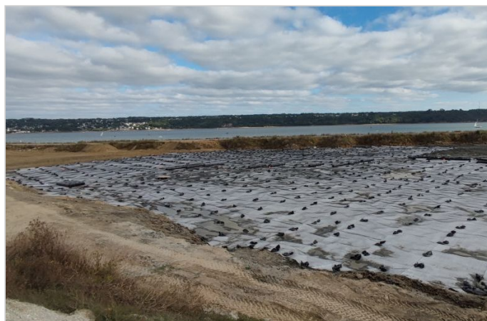
Macgrid CE posée en 2 couches croisées et lestés
