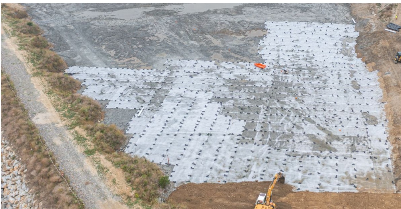
Vue aérienne du chantier
