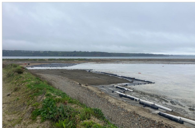
Rouleaux ancrés sous la piste périphérique, déroulés vers le centre du casier
