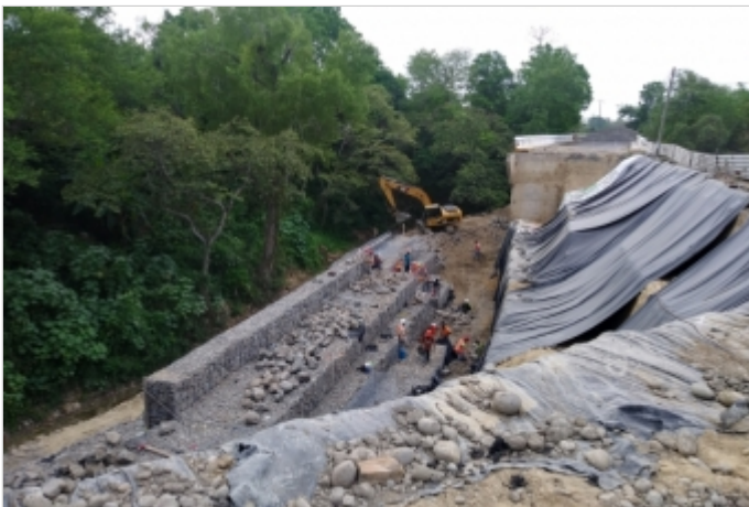
Durante la Obra
