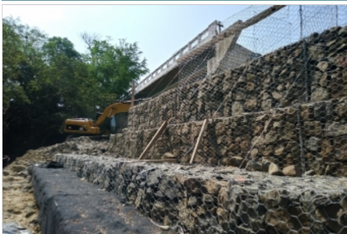
Durante la Obra
