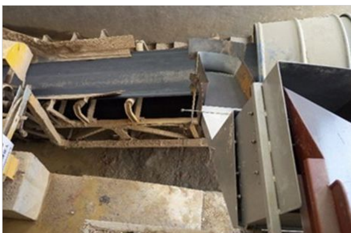
图5 商混站内机械添加钢纤维
