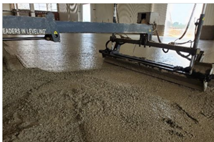
图6 钢纤维混凝土浇筑
