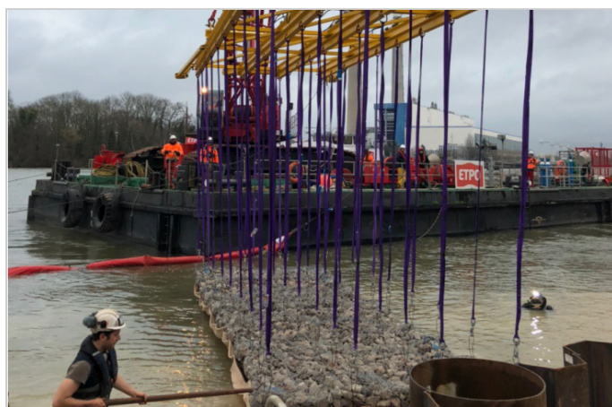
Manutention des matelas Reno préremplis
