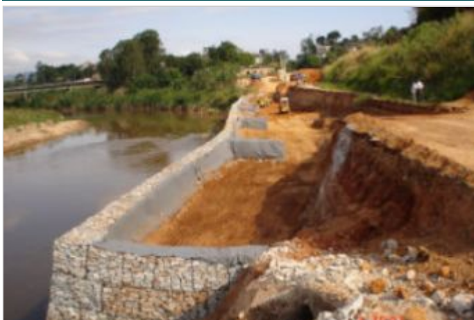
Durante la Obra
