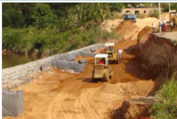
Durante la Obra
