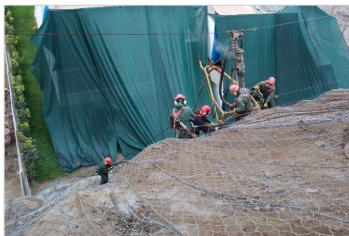
Durante la Obra
