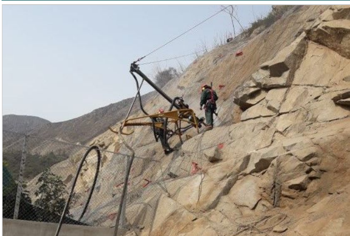
Durante la Obra
