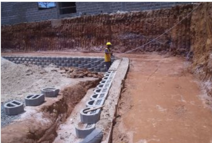
Durante la Obra
