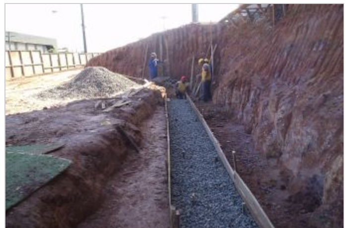
Durante la Obra
