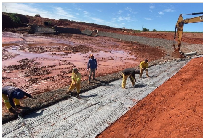
Durante a obra
