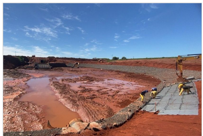
Durante a obra
