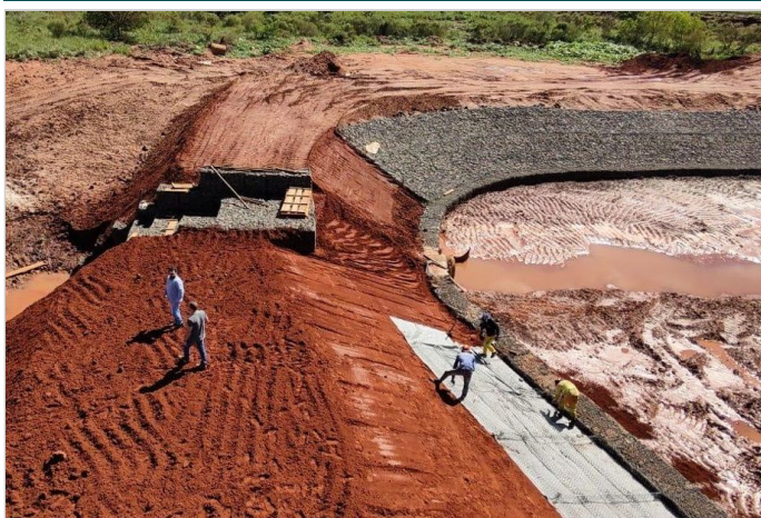
Durante a obra
