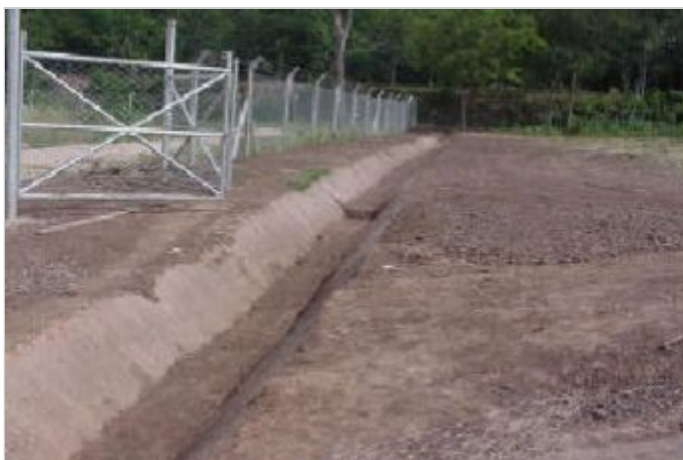
Durante a obra
