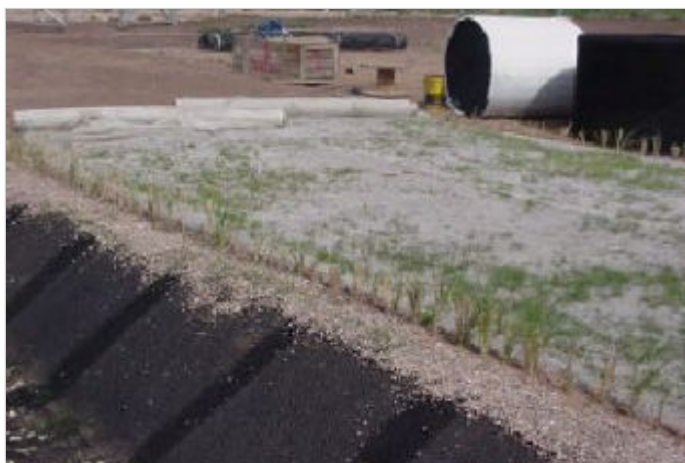
Durante a obra
