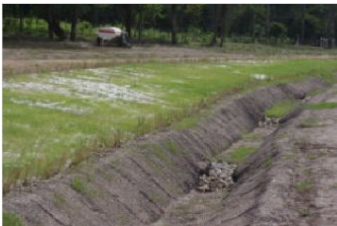
Durante a obra
