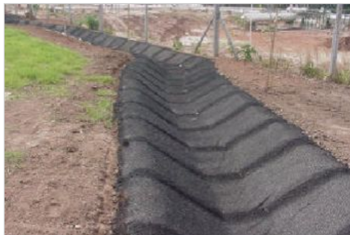
Durante a obra
