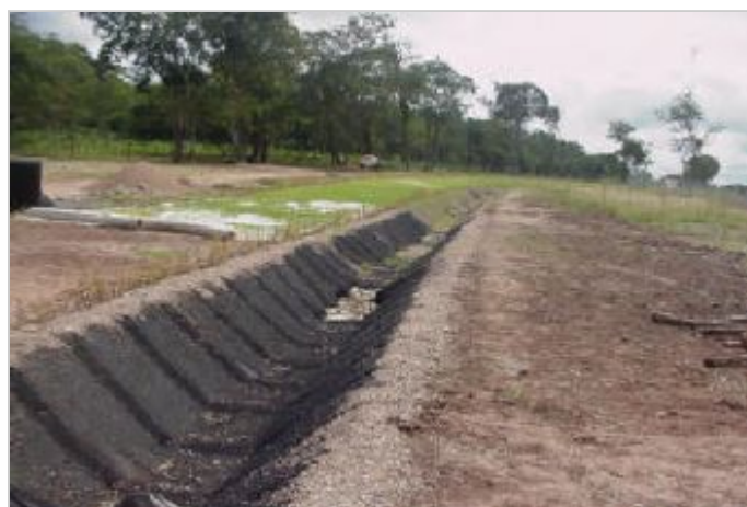
Durante a obra
