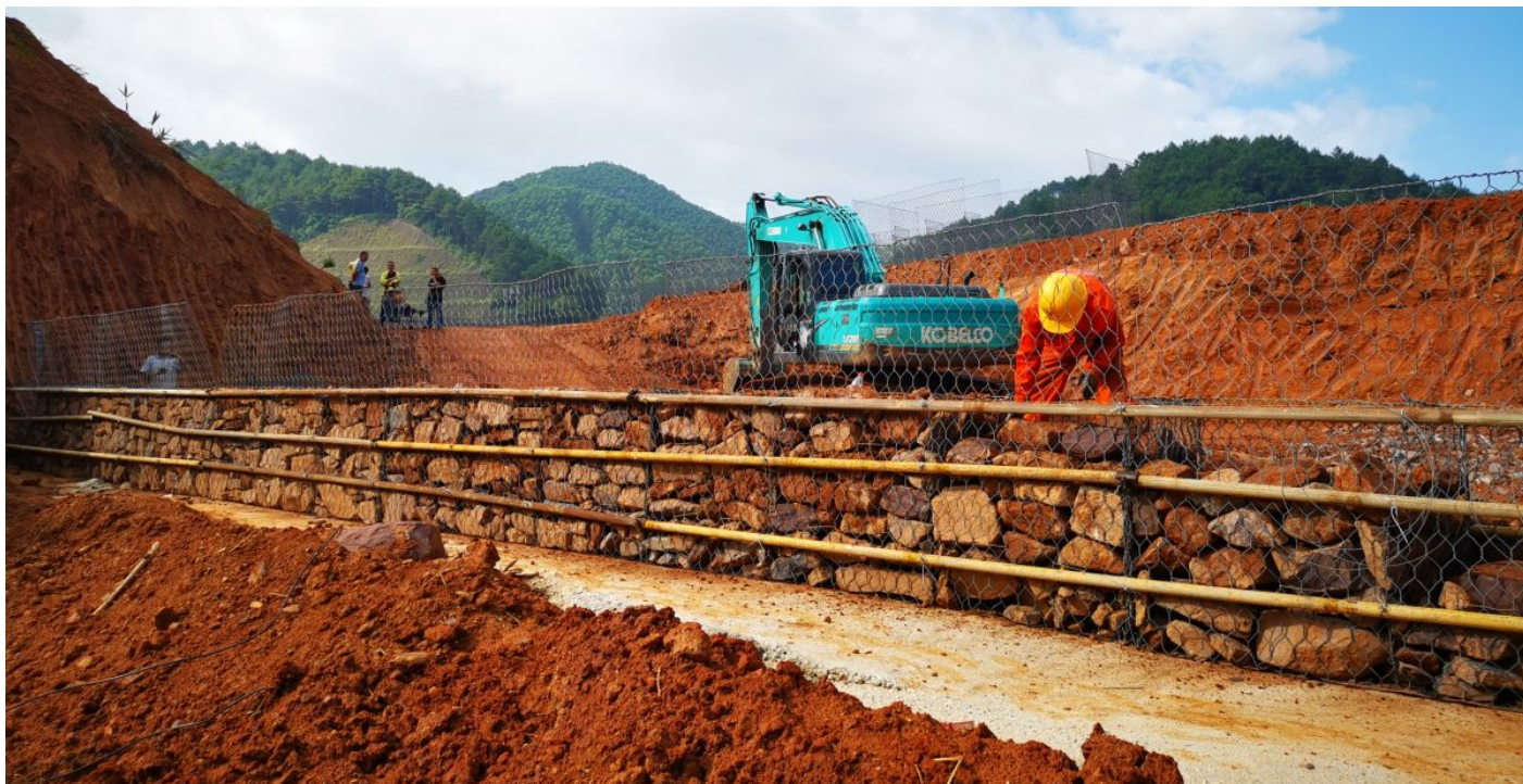
加筋格宾面墙填石
