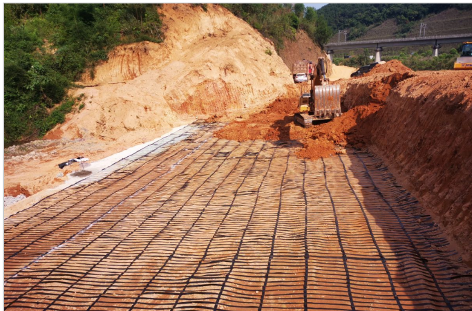
01-格栅铺设及填土
