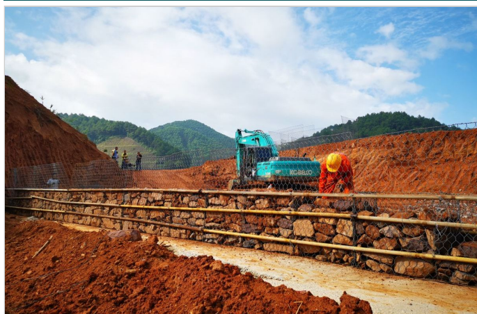
03-加筋格宾面墙填石
