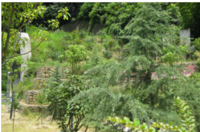
图三：项目竣工3年后照片
