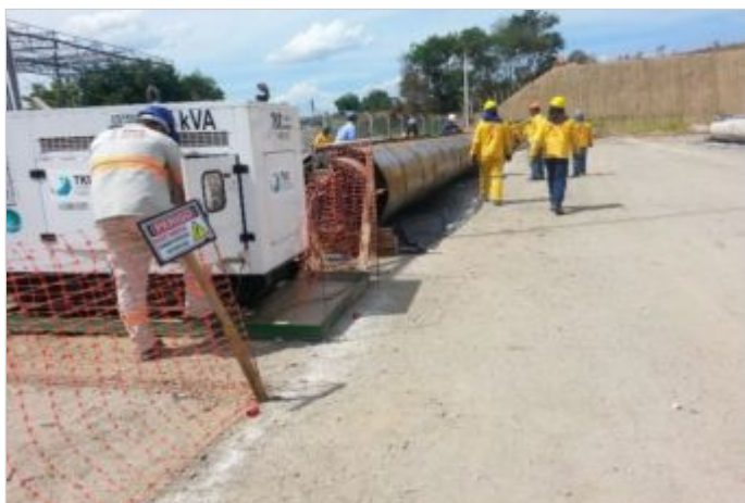
Durante la Obra
