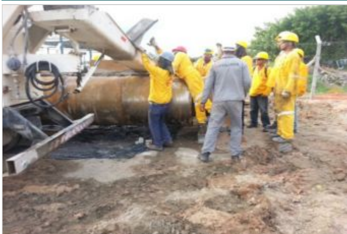
Durante la Obra
