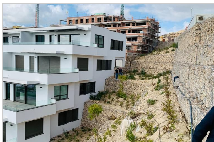
Bermas escalonadas con vegetación y riego
