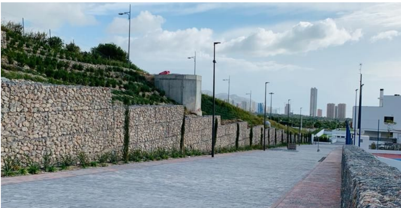
Vista general de la obra
