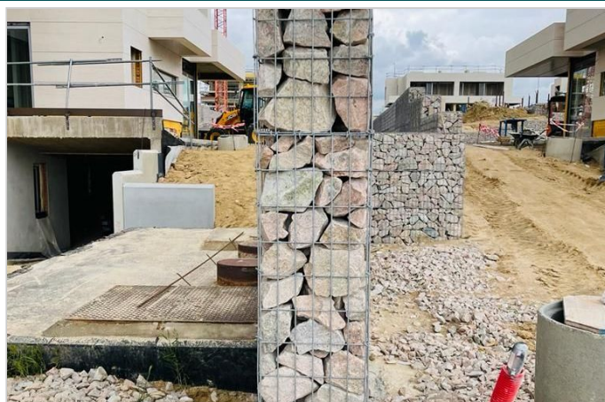
Cerramiento de malla electrosoldada
