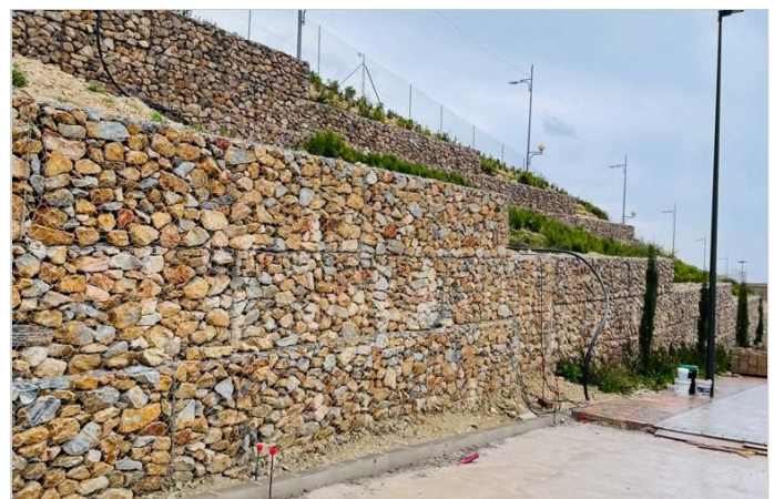
Muro de gaviones
