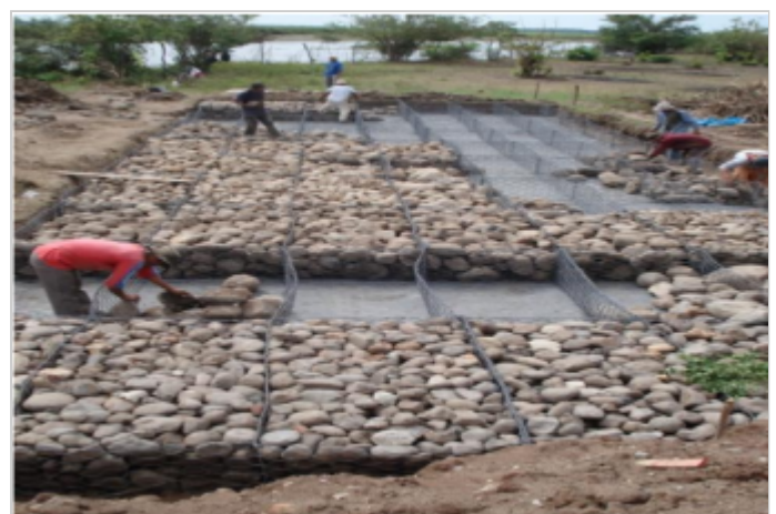
Durante la Obra
