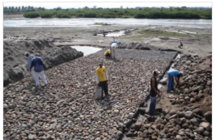
Durante la Obra
