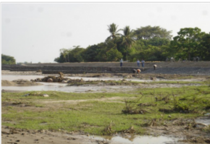
Durante la Obra
