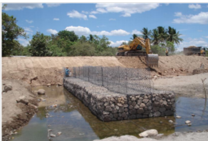
Durante la Obra
