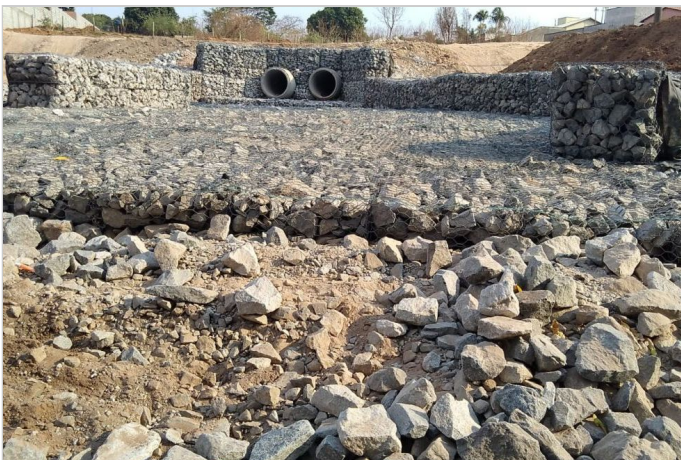
Durante a obra
