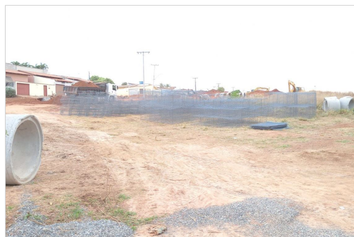
Durante a obra
