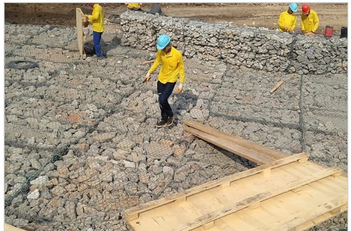
Durante a obra
