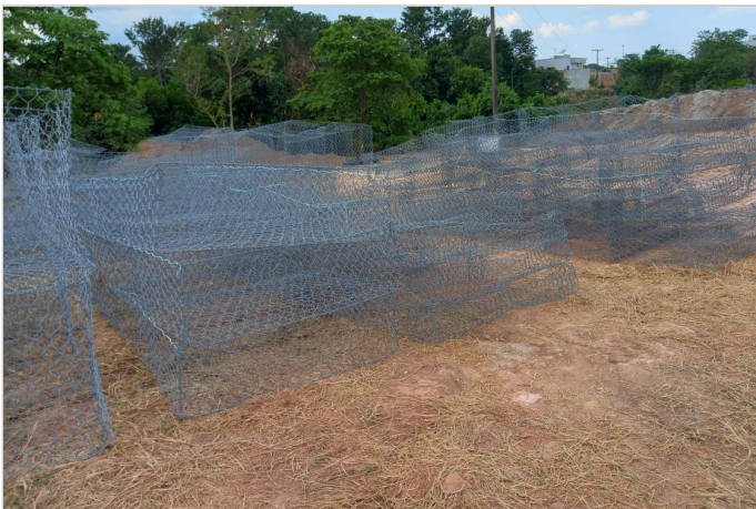
Durante a obra
