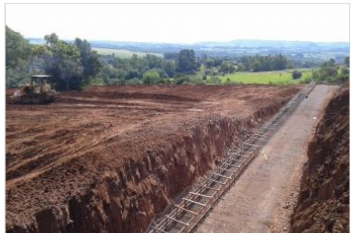
Durante la Obra
