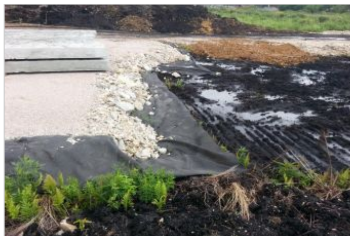
Durante la Obra
