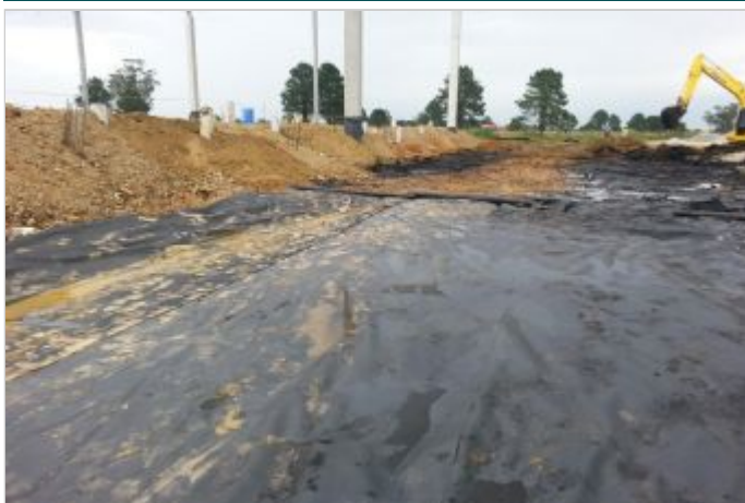
Durante la Obra
