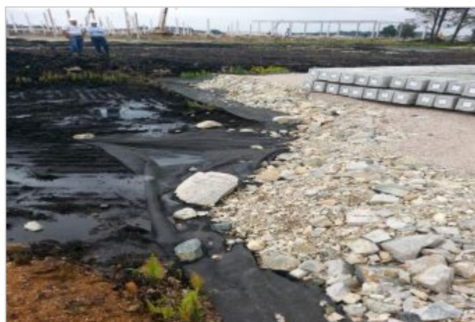
Durante la Obra
