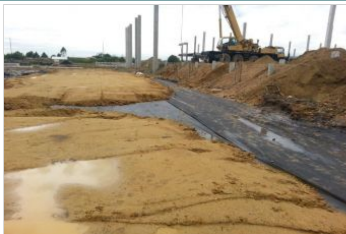
Durante la Obra
