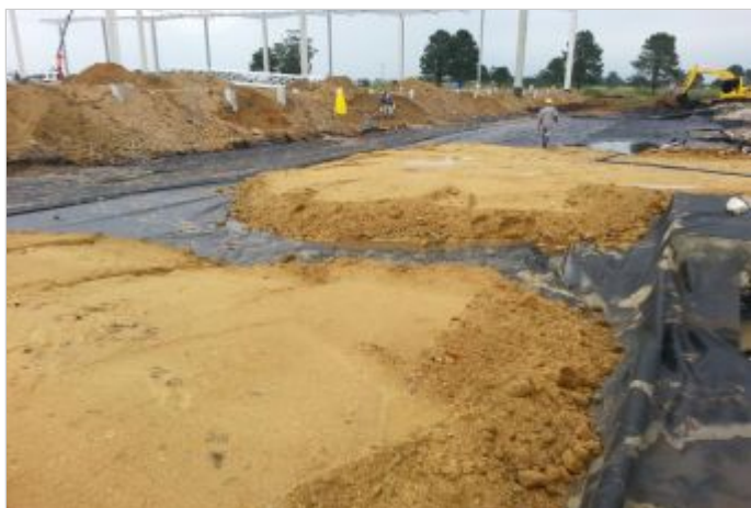
Durante la Obra
