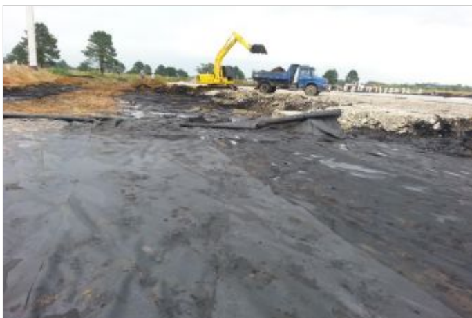
Durante la Obra
