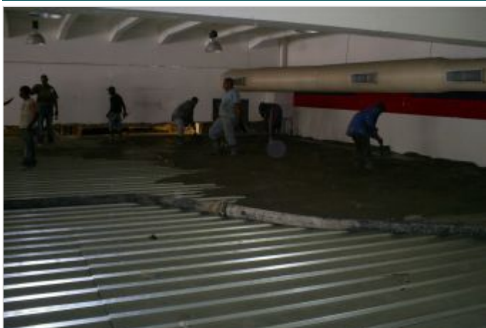
Durante la Obra
