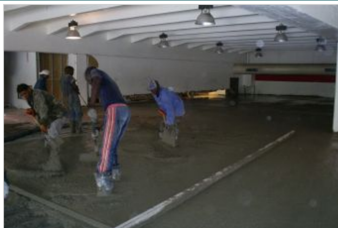
Durante la Obra
