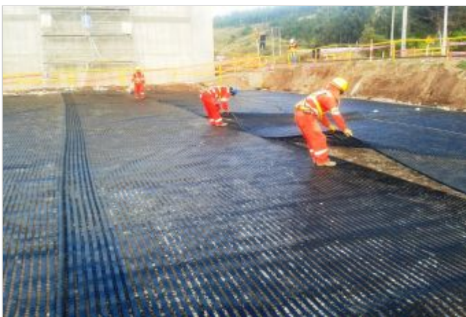
Durante la Obra
