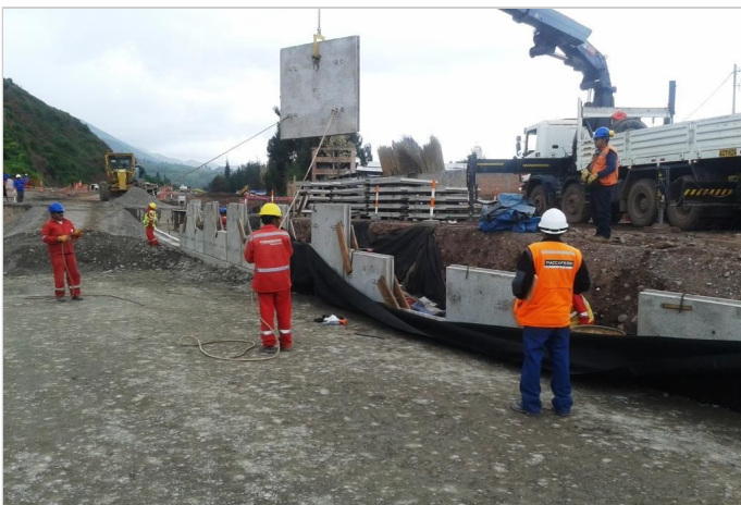
Durante la Obra
