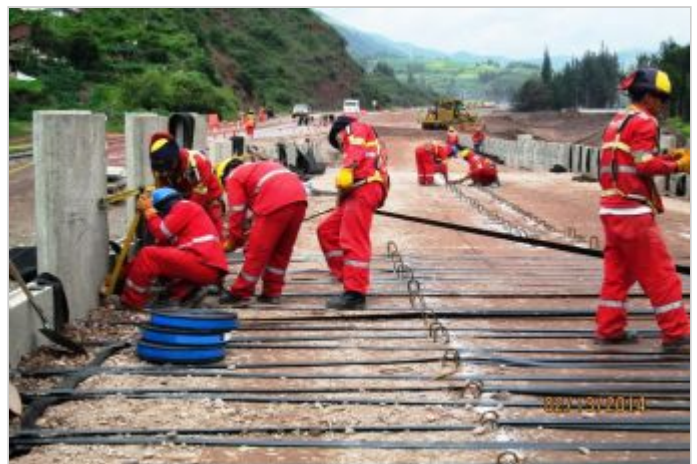
Durante la Obra
