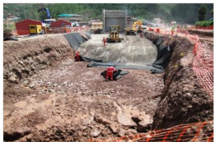
Durante la Obra
