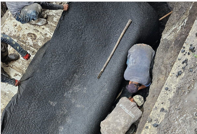
Durante la Obra
