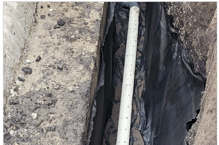
Durante la Obra
