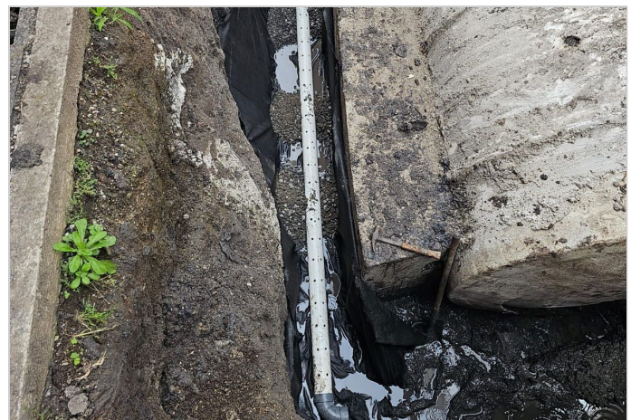
Durante la Obra
