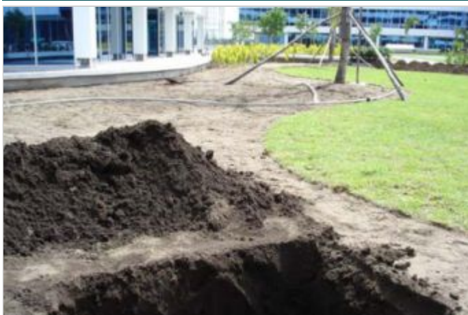
Durante a obra
