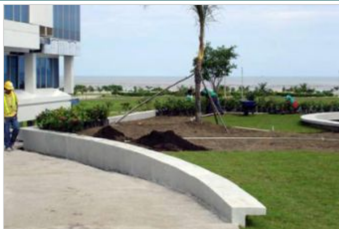
Durante a obra
