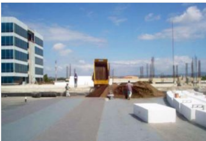
Durante a obra
