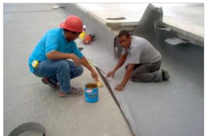
Durante a obra
