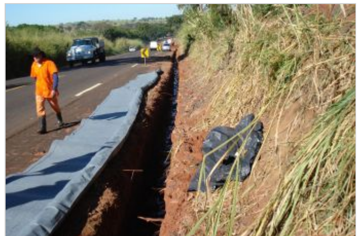
Durante la Obra
