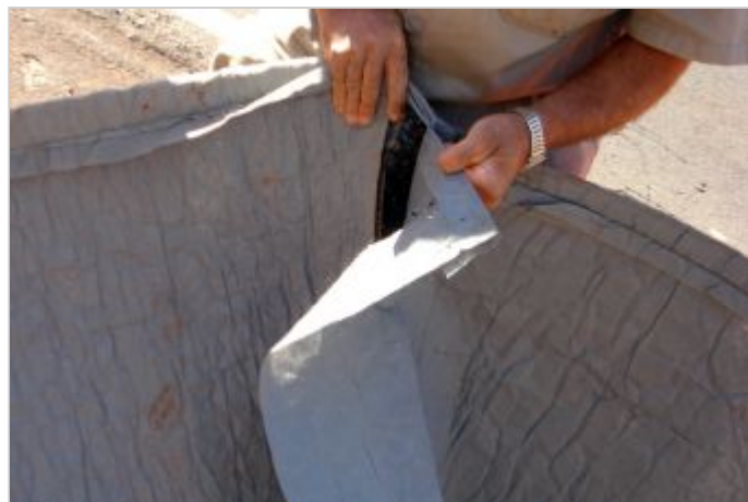
Durante la Obra
