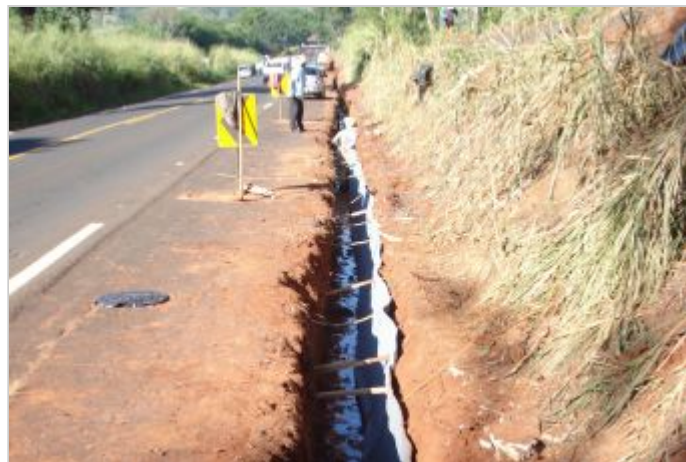
Durante la Obra
