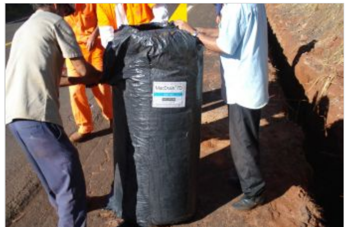
Durante la Obra
