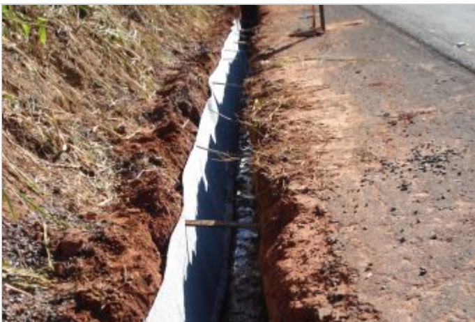
Durante la Obra
