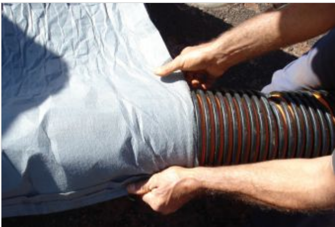
Durante la Obra
