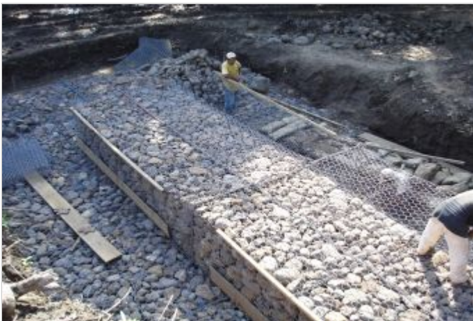
Durante la Obra
