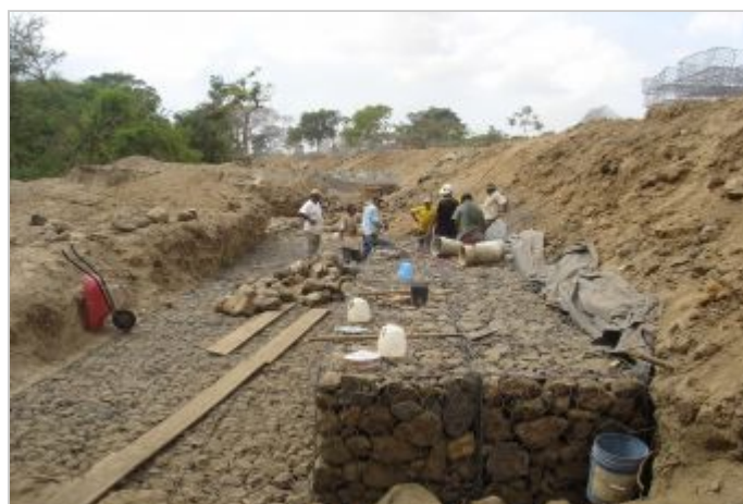
Durante la Obra
