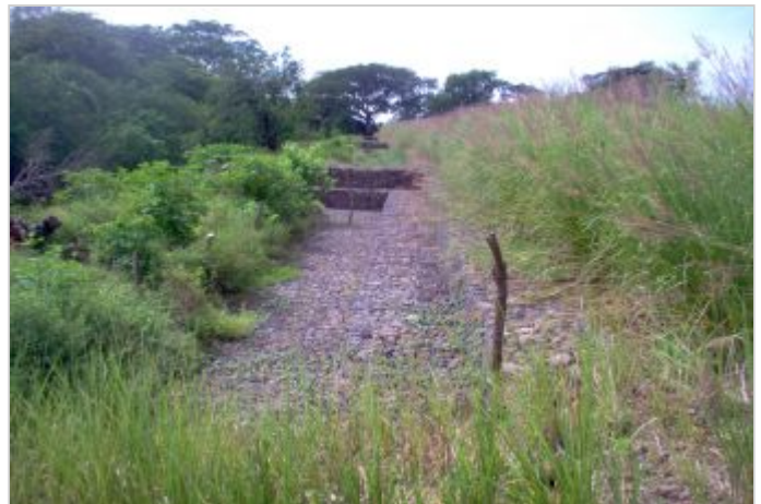
Durante la Obra
