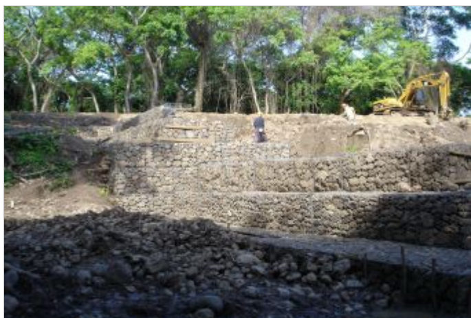
Durante la Obra
