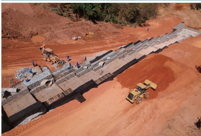
Durante la Obra
