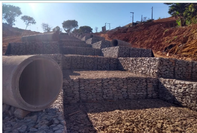
Durante la Obra
