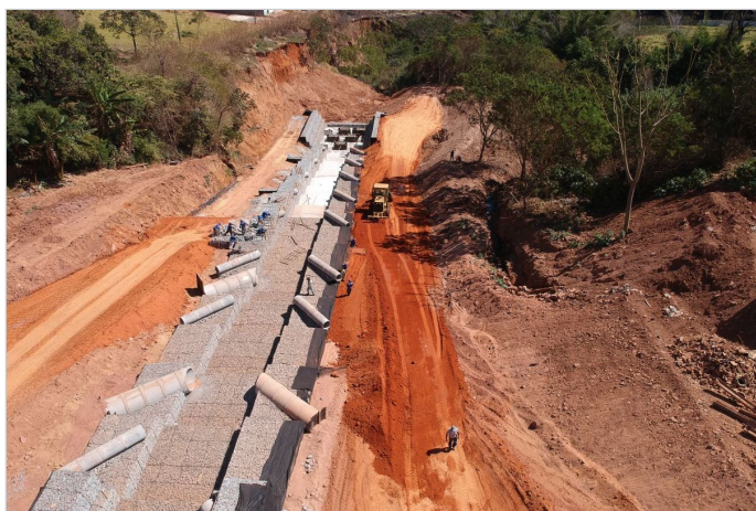
Durante la Obra
