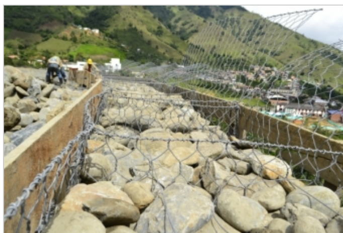
Durante la Obra
