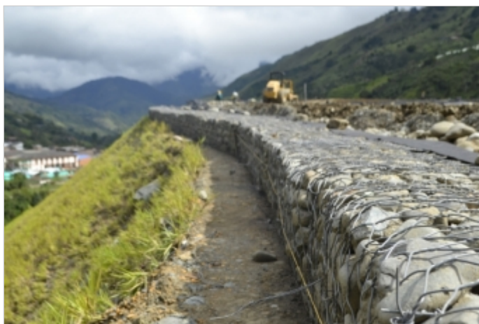
Durante la Obra
