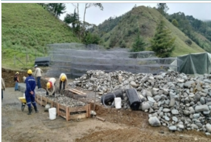
Durante la Obra
