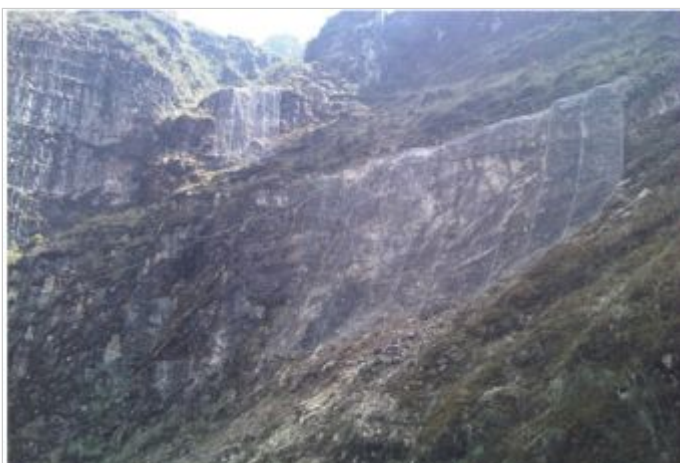
Durante la Obra
