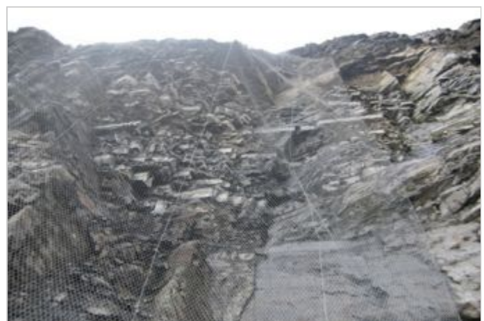
Durante la Obra
