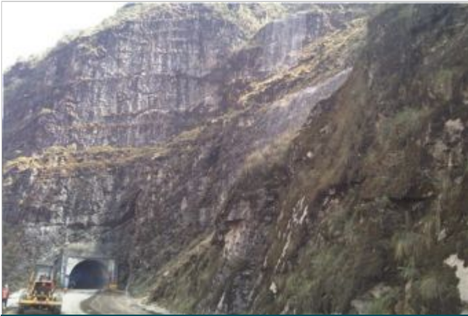
Durante la Obra
