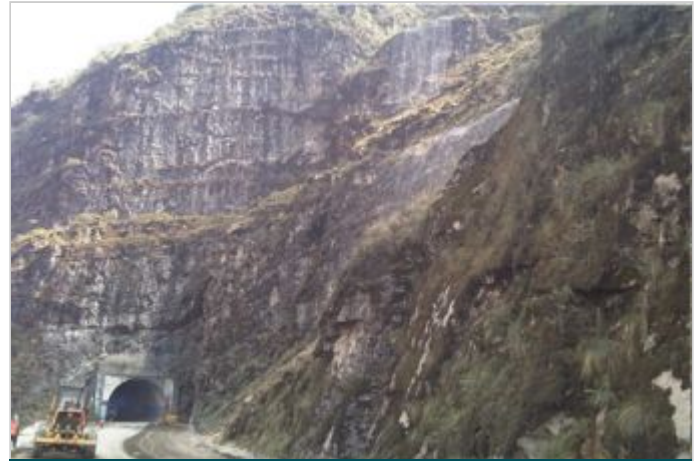
Durante la Obra
