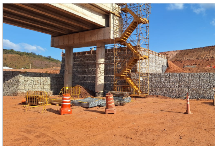
Durante a obra
