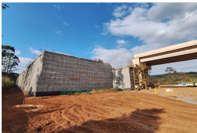
Durante a obra
