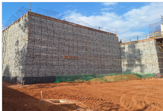
Durante a obra
