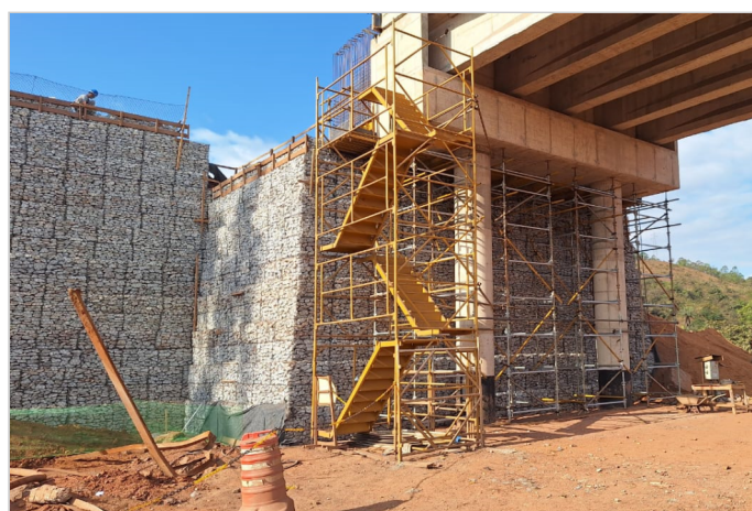
Durante a obra
