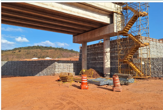
Durante a obra
