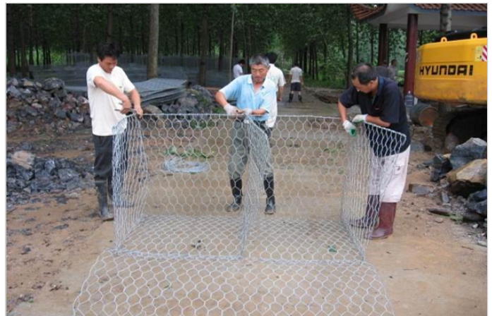
施工中 工地现场组装，人工绞合
