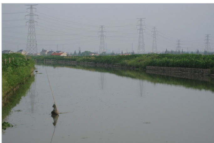
施工后 与周边自然环境的完美结合
