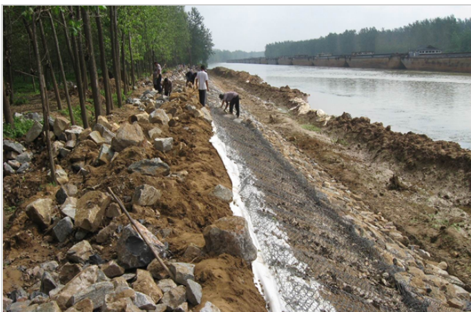
施工中 铺设雷诺护垫，下垫土工布
