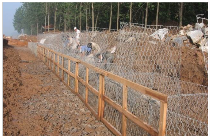
施工中 现场支模板、填充石料
