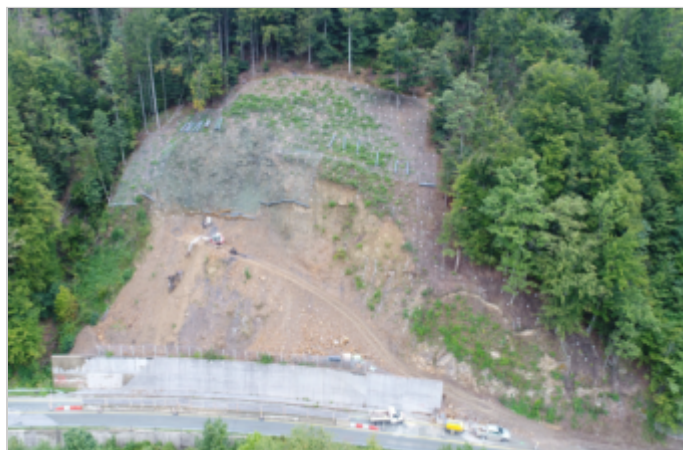
Prvá fáza sanácie svahu (September 2017)
