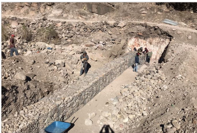
Durante la Obra
