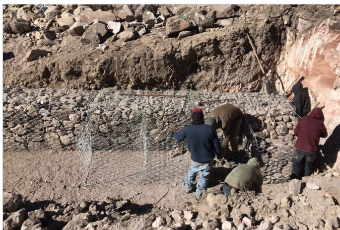
Durante la Obra
