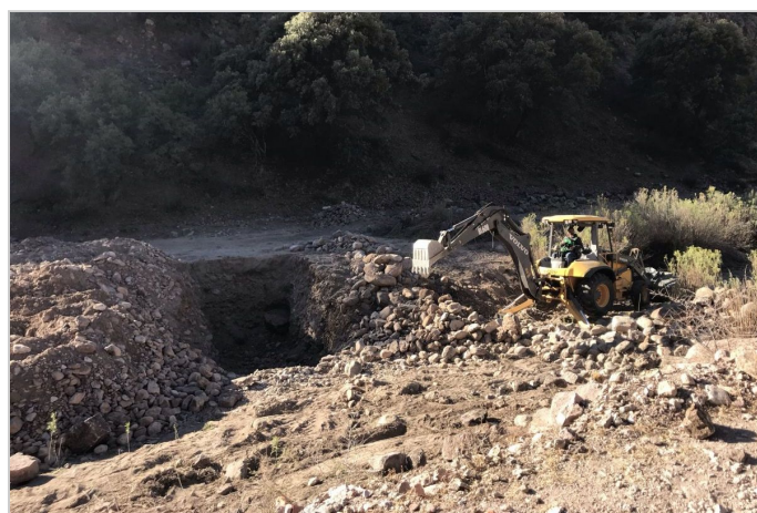
Durante la Obra
