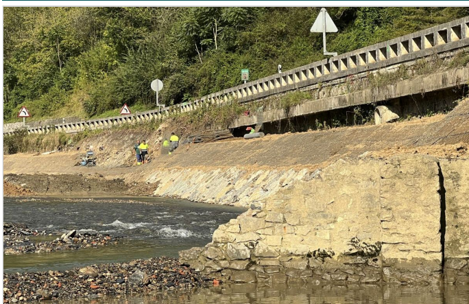
Instalación del Sistema Green Terramesh
