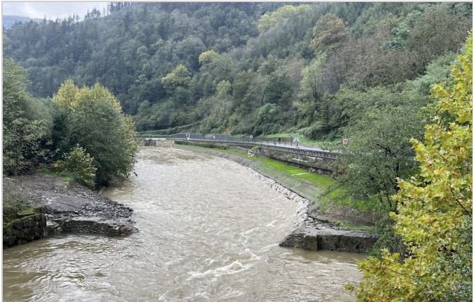
Inicio de revegetación del Sistema Green Terramesh
