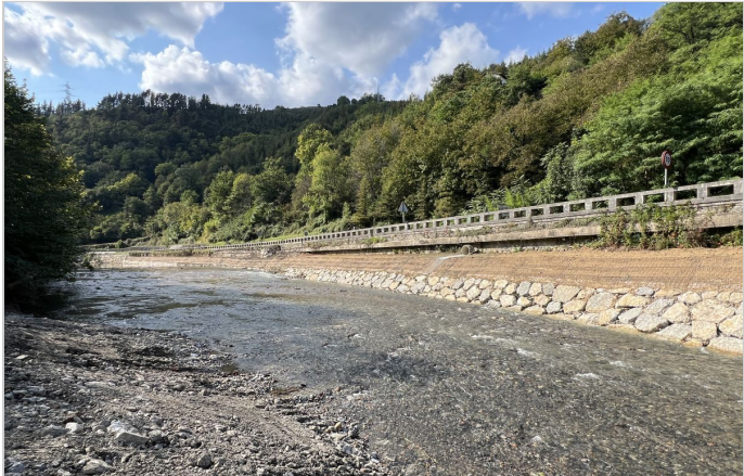
Finalización del muro de suelo reforzado con el Sistema Green Terramesh
