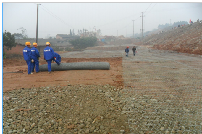
整平场地铺设网面
