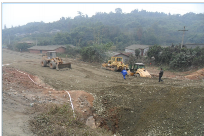
上部土层的施工
