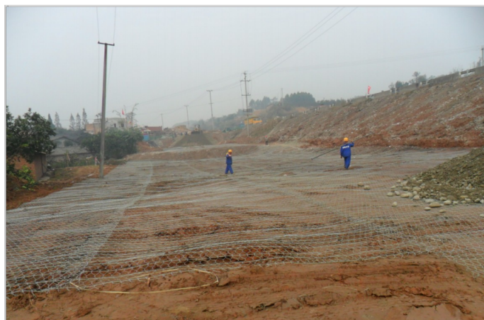
路面加筋网搭接
